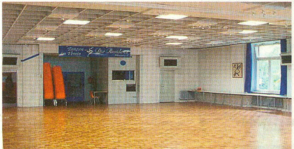
So sah der jetzige Tanzsaal bis vor etwa drei Monaten aus. Die Akustikdecke an einem Drahtgeflecht verringerte die Raumhöhe auf 3,40 Meter. Foto: privat
