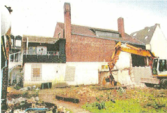
Das innenliegende Gartengrundstück wird für die Erweiterung des Plus-Marktes bebaut. Fotos: WAZ, von Staegmann
